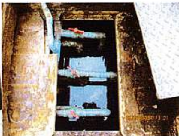
บ่อตกตะกอน Sedimentation Tank 1 ระดับน้ำสูงมาก เนื่องจากมีน้ำจากคลองสาธารณะไหลเข้ามาสู่ระบบ
