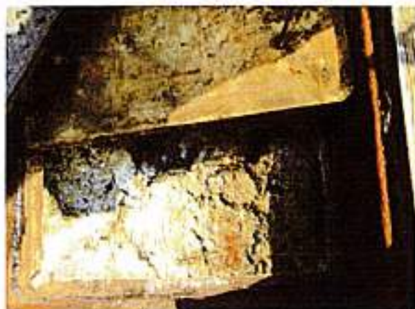
EQ. Tank 2 ระดับน้ำเสียสูงมากตกดอยมาก
