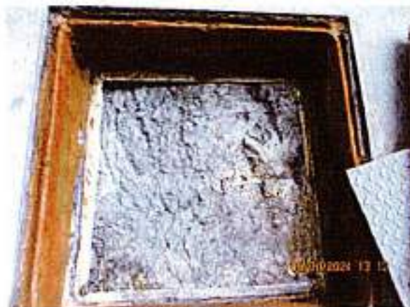
EQ. Tank 1 ระดับน้ำเสียสูงมากจนล้น
