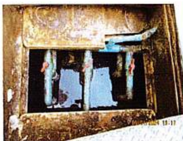
บ่อตกตะกอน Sedimentation Tank 1 ระดับน้ำสูงมาก เนื่องจากมีน้ำจากคลองสาธารณะไหลเข้ามาสู่ระบบ
