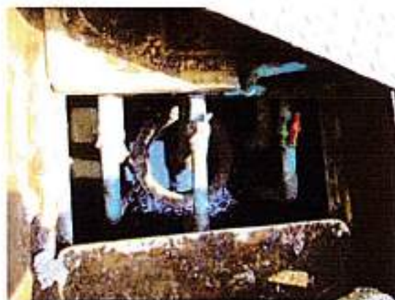
บ่อตกตะกอน Sedimentation Tank 2 ระดับน้ำสูงมาก เนื่องจากมีน้ำจากคลองสาธารณะไหลเข้ามาสู่ระบบ
